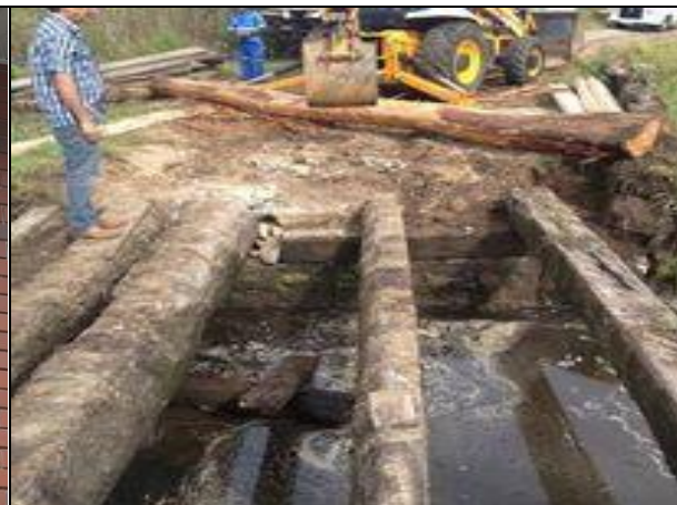
FOTO 02 – Drenagem pluvial área rural
