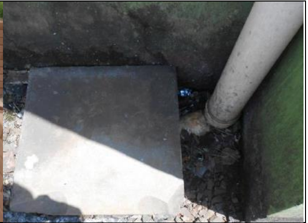
FOTO 02 – Caixa de inspeção
