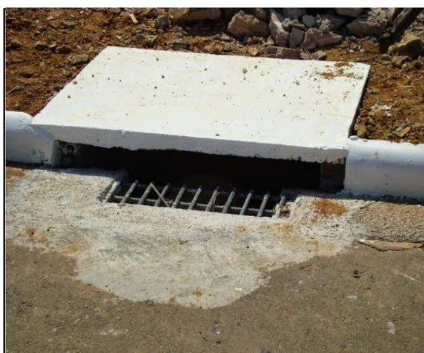
FOTO 05 – Boca de lobo (tipo chapéu)
