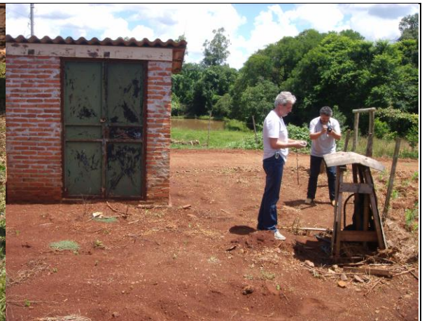
FOTO 02 – Estação Elevatória de Água Bruta
