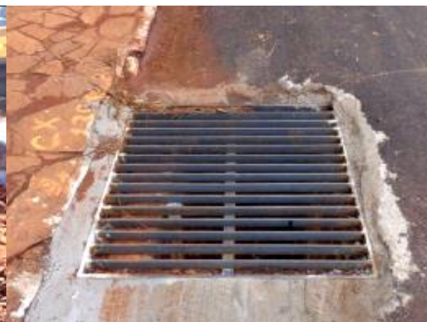
FOTO 04 – Boca de lobo (grelha)
