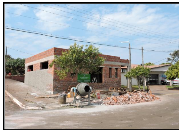
FOTO 06 – Disposição dos RCC
