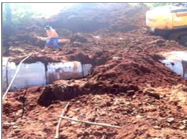
FOTO 03 – Obra rural de drenagem
